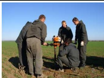
Бурение скважин производится мотобуром на глубину 0,5-1,5 метра.
